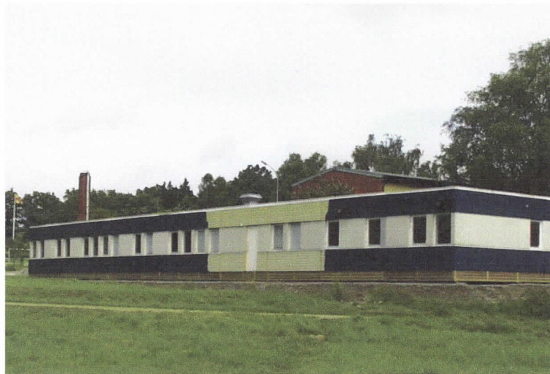
Nu vill skollneden för Prästängsskolan åter placera en paviljong för skolverksamheten på den numera så utnyttjade skoltomten. Anledningen är att den nyligen presenterade skolutredning totalt misslyckats i beräkningen av elevantalet.
