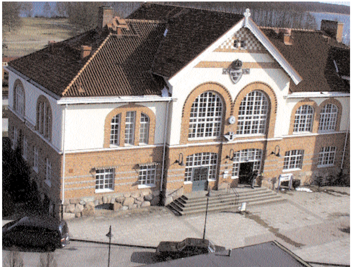
Trappor blir också i framtiden den genomgående sätten att ta sig till och från tågen i Alvesta nya Resecentrum. Rulltrapporna är av ekonomiska skäl borttagna. Frågan är vad som en gång blir kvar av det storslagna projektet.
