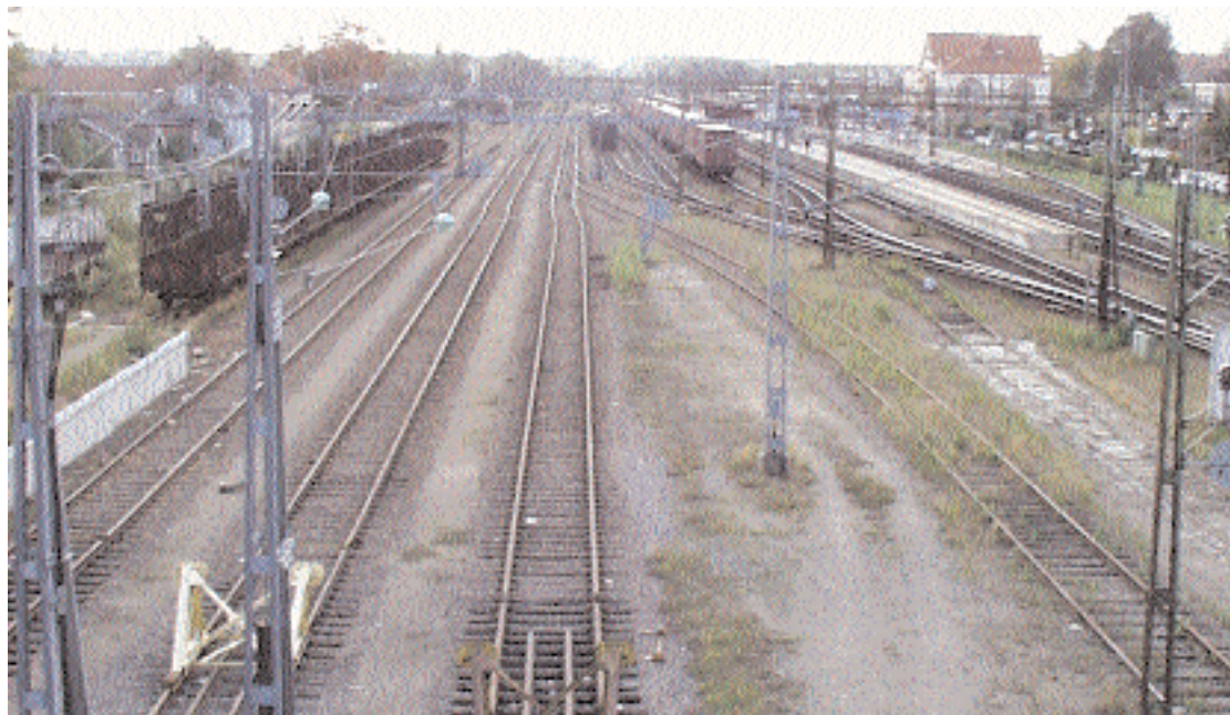
Med all den trafik som skall tillkomma närmar sig en utflyttning av godsbangården med stormsteg. Bara det faktum att godstågen blir längre gör att något radikalt måste till för att knutpunkten skall kunna utvecklas.
