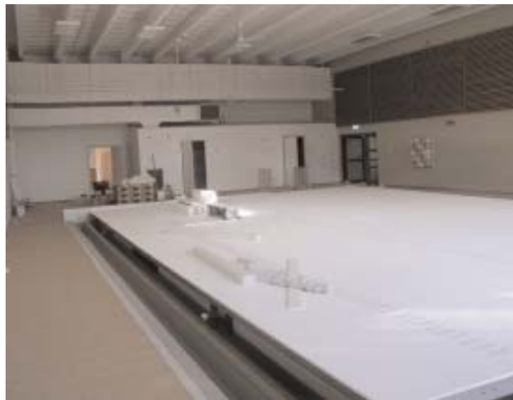
Golvet till varmvattenbassängen ligger fortfarande över vattenytan, men snart är det dags att sänka ned det i sitt rätta element.
